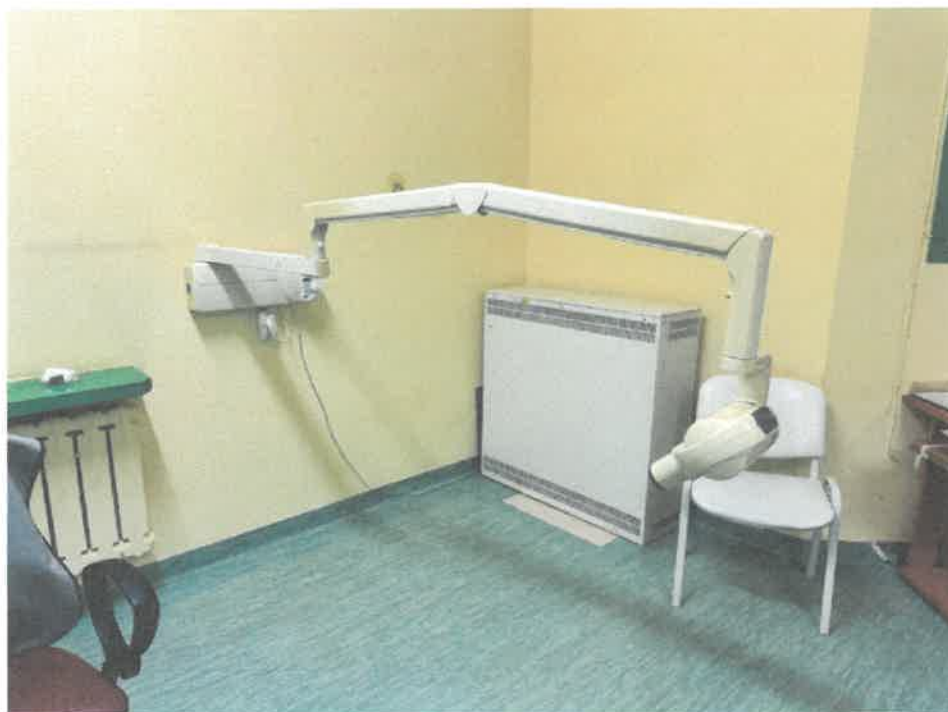
Zdjęcie nr 6 - aparat RTG zębowy – punktowy z ramieniem o długości 205cm
